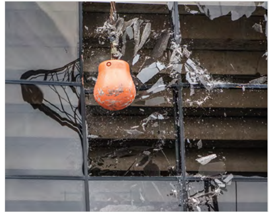
Bild 1-6: Abrissbirne im Einsatz
