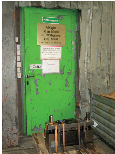
Abb. 18: Verschlussener Notausgang (links) und dazu noch verbotener Schlüsselkasten (OVG.NW Urteil vom a 1766/90; BVerwG Beschluss vom B5592 OVG Münster) (rechts) für den auch noch das Hilfsmittel zum Einschlagen der Scheibe fehlt.
