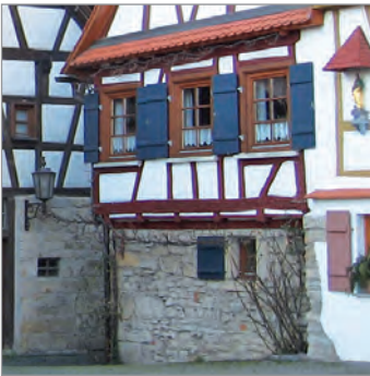
Bild 2.1: Fachwerk mit Mauerwerk
