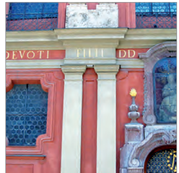
Bild 2.8: Fassade mit Gesims, Pilaster und Baudekor
