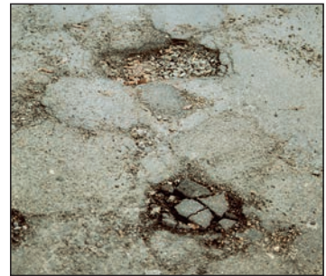
Bild 2: Frosts Schäden
