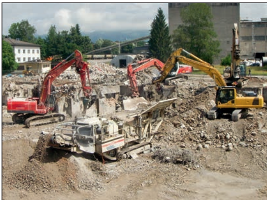
Bild 4: Abbruch und Wiederaufbereitung von Beton
