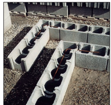
Bild 2: Mauerecke mit Schalungssteinen
