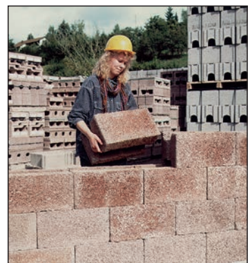
Bild 3: Mauerreinbindung mit Schalungssteinen aus Holzspanbeton
