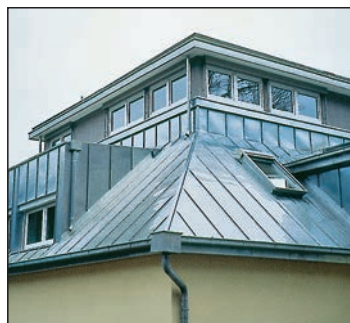
Bild 2: Deckung mit verfalzten Blechen
