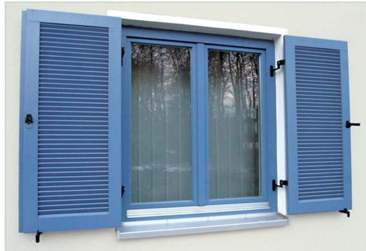
2. Fensterprofile bestehen entweder aus Holz, Aluminiumlegierungen oder PVC-U. Den größten Marktanteil nimmt zur Zeit PVC-U mit über 50 % ein.
