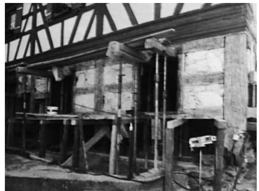
LINKS UND UNTEN: Sanierung des Fachwerks im Erdgeschoss.
