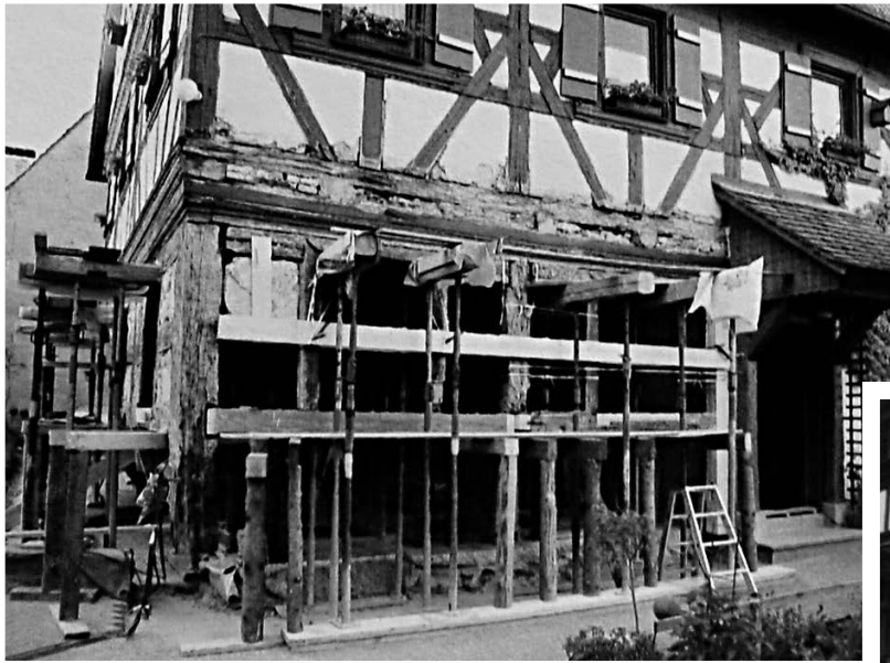
LINKS UND UNTEN: Sanierung des Fachwerks im Erdgeschoss.
