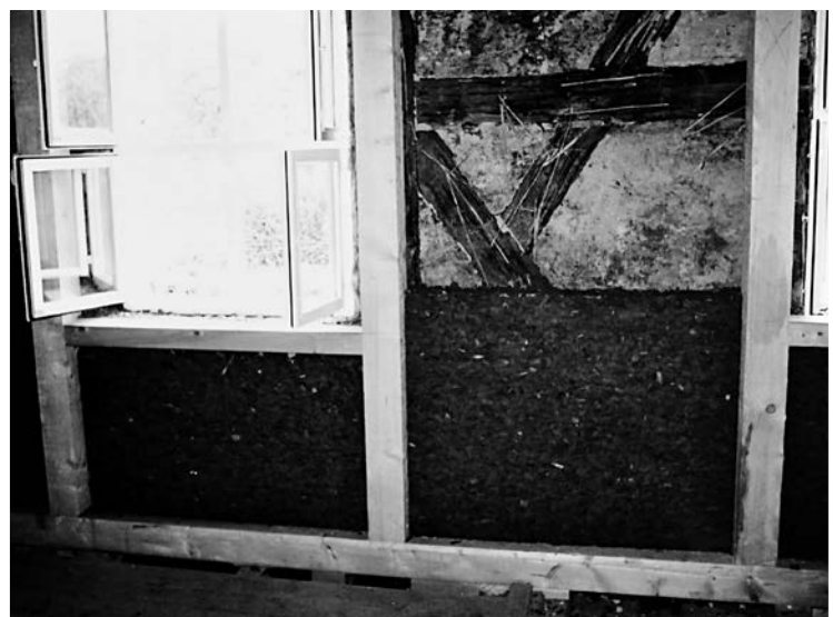
LINKS UND UNTEN: Innendämmung mit Schilfmatten und Lehm.
