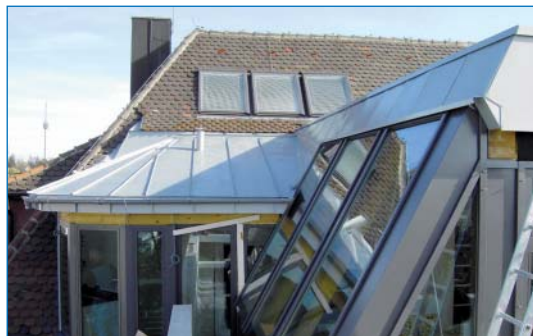
Bild 2: Die gleiche Baustelle aus einem tieferen Blickwinkel: Anschlüsse an Glas und die Brüstungsabdeckung unten
