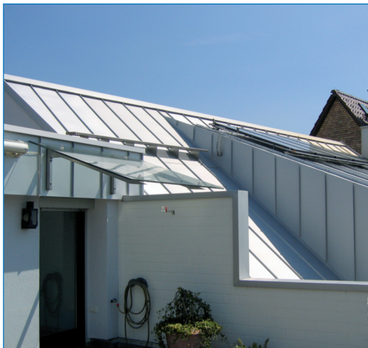
Bild 1: Titanzinkdach walzblank
