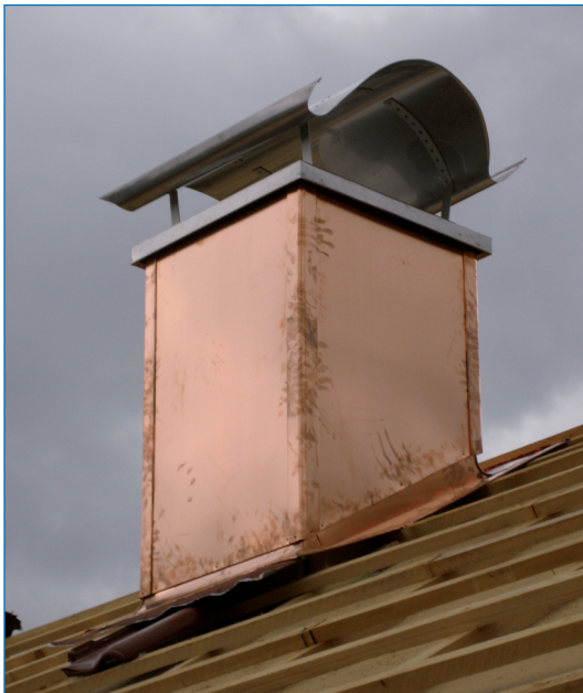
Bild 1: Kupferkaminmantel mit Edelstahlabdeckung und Edelstahlhut
