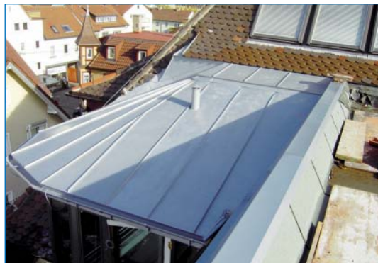
Bild 1: Die Baustelle eines Klempners: Anschlüsse seines Daches an das Ziegel- und Flachdach anderer Gewerke
