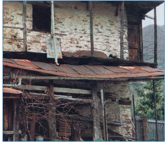
Bild 2: Durchgerostete Bleche – einst der Schrecken jedes Bauherrn, heute als Gartenaccessoire gut verkäuflich
