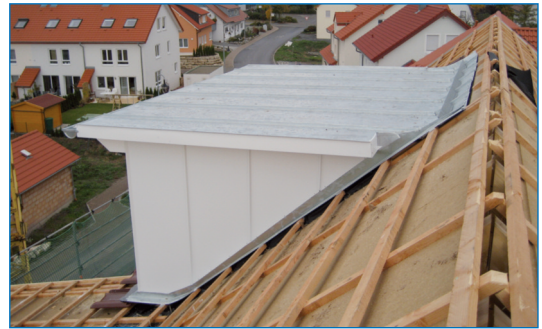
Bild 2: Dachgaube mit Farbaluminiumdach (Korrosion) und Titanzink in der Seitenbackenbekleidung
