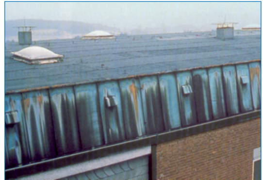
Bild 2: Kupferfärbungen infolge Bitumensäure-Einwirkung.
