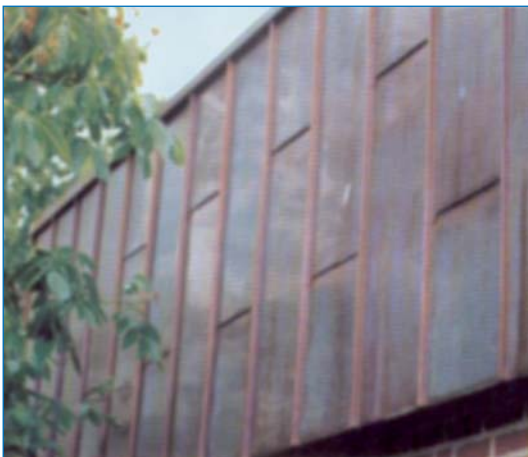
Bild 2: Einfärbungen mit Übergang von braun zu grün ohne Schwarzanteil
