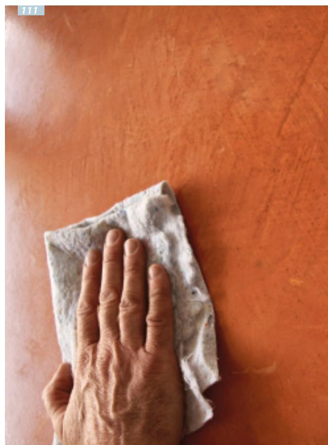
Der Auftrag erfolgt zügig vom Nassen ins Trockene, wolkig und in jede Richtung. Die Auftragsstärke ist minimal, indem das großzügig aufgelegte Material sofort ab- und in die benachbarten Bereiche hineingezogen wird.
