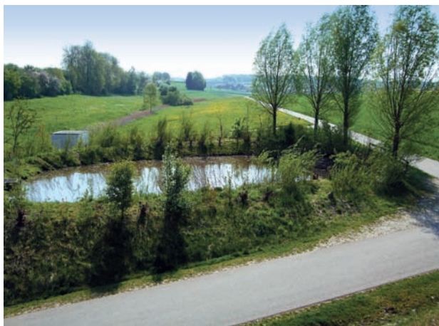
Bild 2: Ein künstlich angelegter Teich, der durch einen kleinen Bach ständig mit Wasser versorgt wird und über Fahrwege erreichbar ist, stellt eine ideale Löschwasserversorgung am Ortsrand dar.
