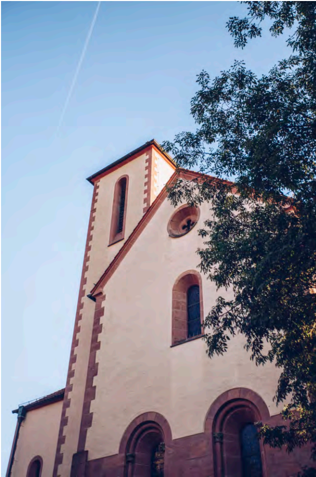
Peterskirche (nördliches Querhaus)
