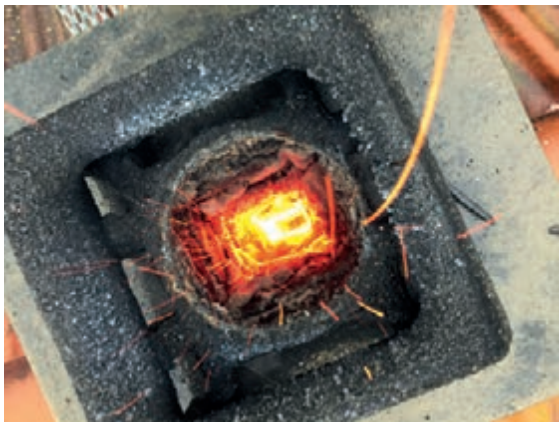
Bild 1: Schornsteinbrand mit Blick in die Schornsteinmündung (Foto: Maximilian Heep)
