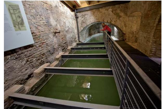
Über das Aquädukt unter der Bastion am Roten Tor wurden bis 1848 reines Trinkwasser und Treibwasser für die Wasserräder parallel ins Wasserwerk geleitet.
