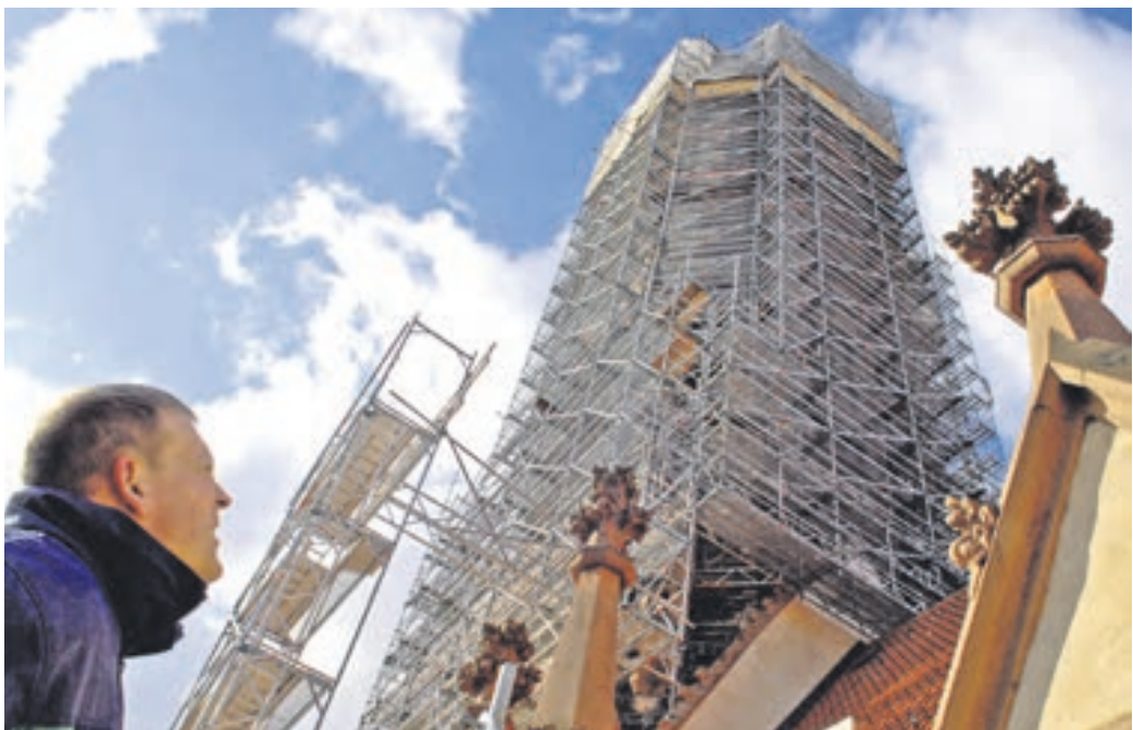
Ins Gerüst gehüllt: Der Jacobi-Kirchturm zu Beginn der Sanierungsarbeiten.
