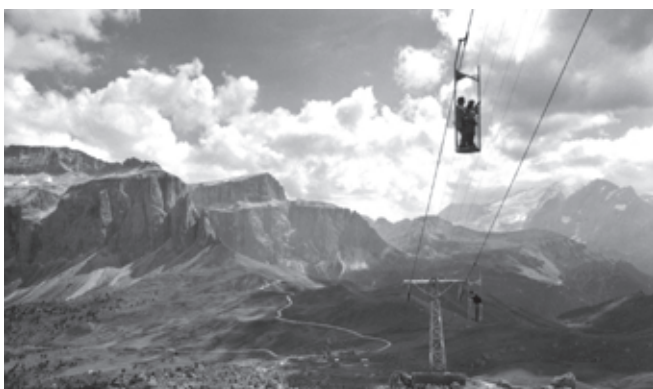
Seggiovvia Col Alto. Carrello, pali in legno e funi della prima seggiovia in Italia collaudata per il trasporto persone
