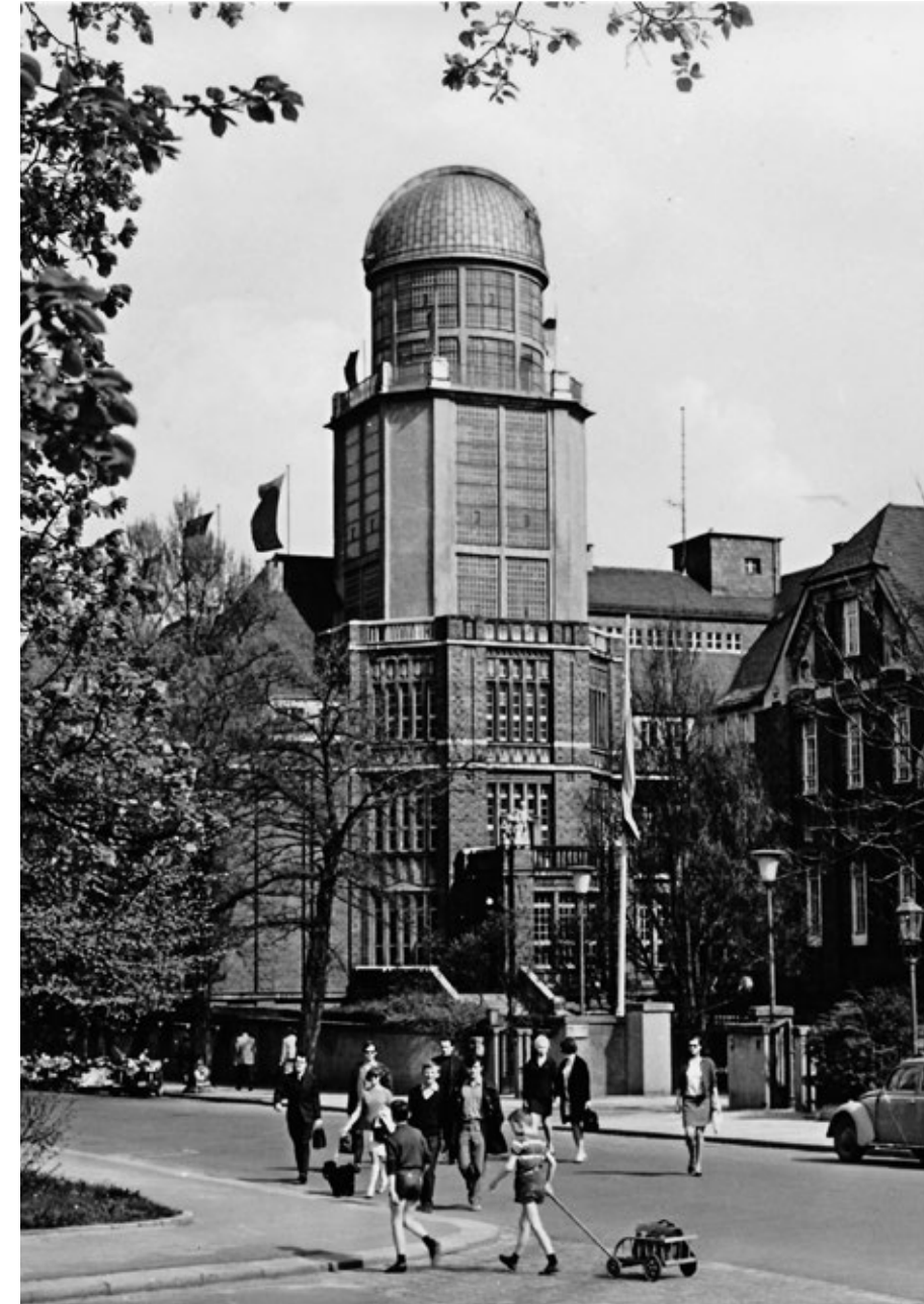
Ochs gab dem Stahlbetonskelettturm mit der Ausfachung in Glasbausteinen ein neues Erscheinungsbild.
