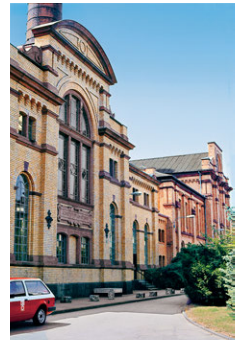
Abb. 12 Das Elektrizitätswerk am Zugweg wurde 1891 in Betrieb genommen. Mit den parallel entstandenen Wasserwerken ist es heute ein Denkmal der Industriekultur.
