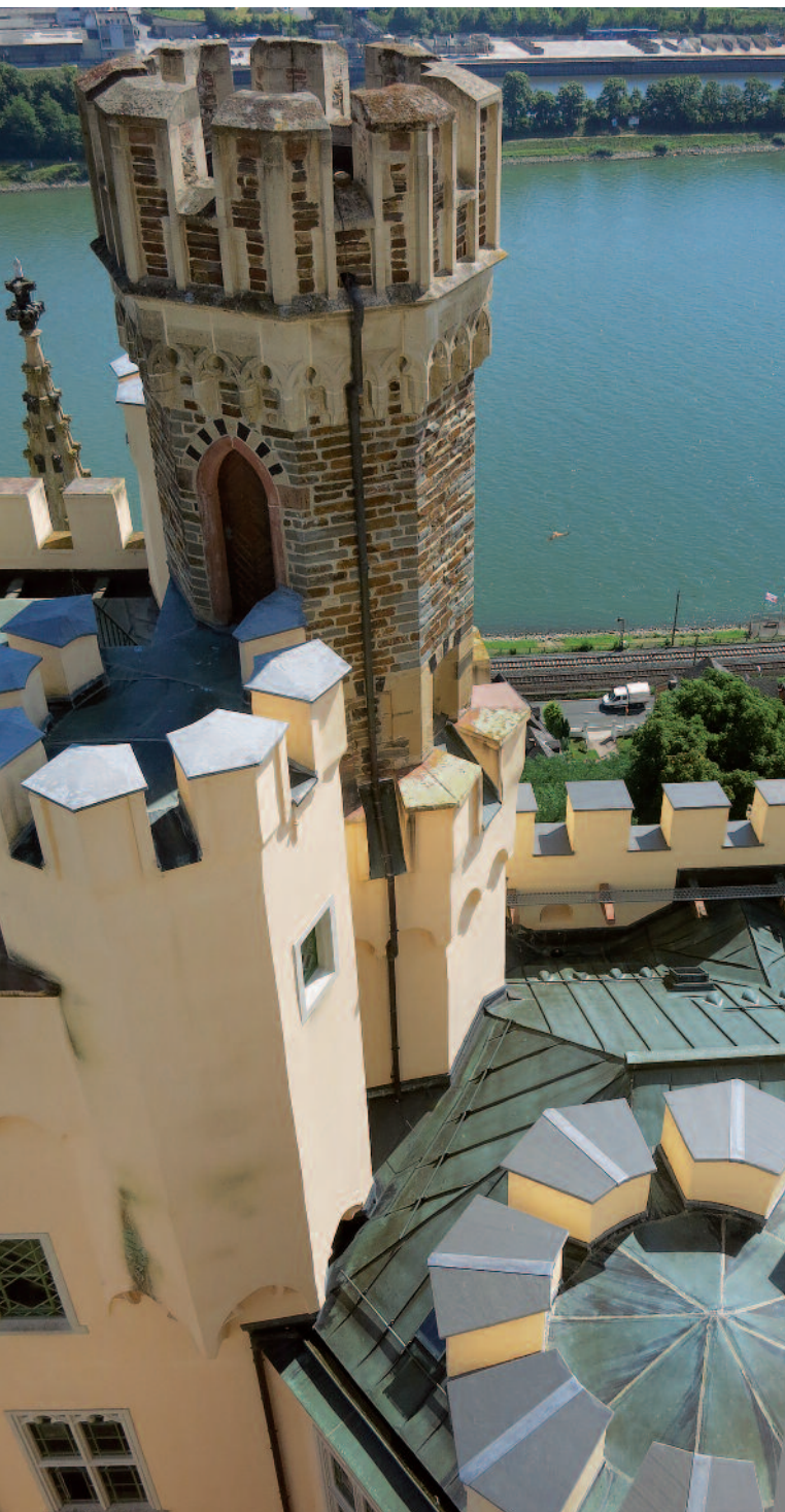
Abb. 10: Wohnturm und Innerer Torbau, unterschiedliche Zinnenabdeckungen nach der Instandsetzung
