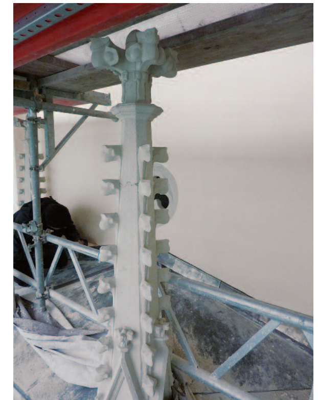
Abb. 12: Innerer Torbau, rheinseitiger Erker, Fialschaft aus Bruchstücken wieder zusammengefügt, oberer Teil der Kreuzblume rekonstruiert
