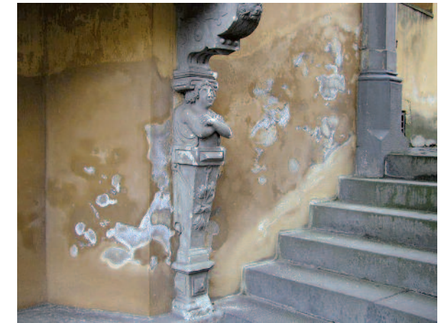
Abb. 2: Kamin in der Arkadenhalle, Putzschäden und Versalzungen
