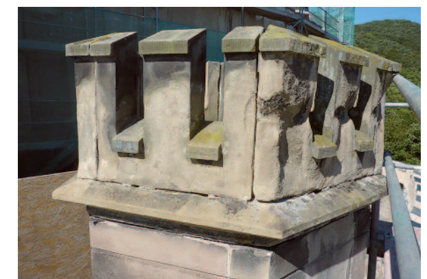
Abb. 13: Nordosttürmchen an der Rheinterrasse vor der Instandsetzung, Konstruktion aus großen Sandsteinplatten
