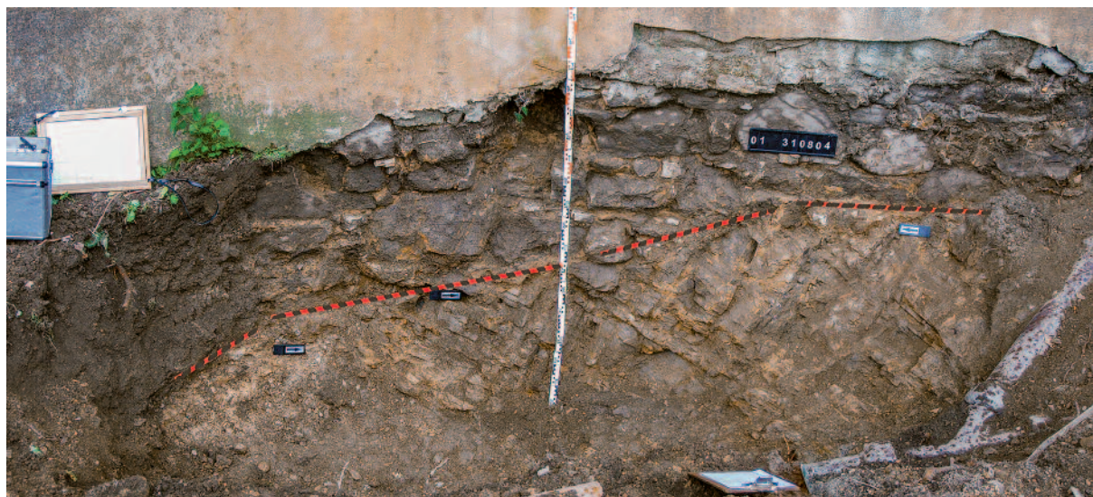
Abb. 2: Nordwestbau, Schürfgrube zur Erkundung der Gründungssituation
