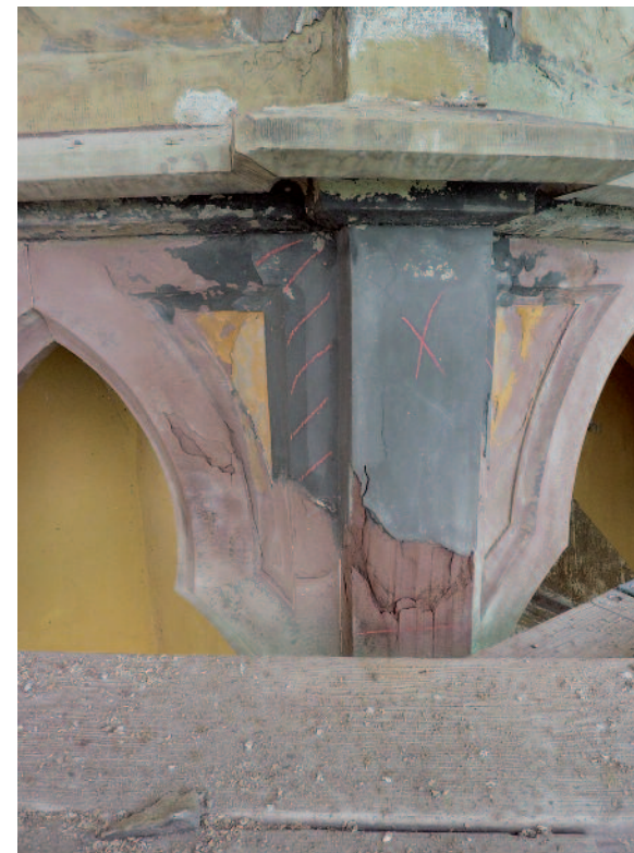
Abb. 11: Innerer Torbau, rheinseitiger Erker, unpassende Ergänzung mit hartem und dichtem Zementmörtel, Steine darunter und in der Umgebung ruinös geschädigt
