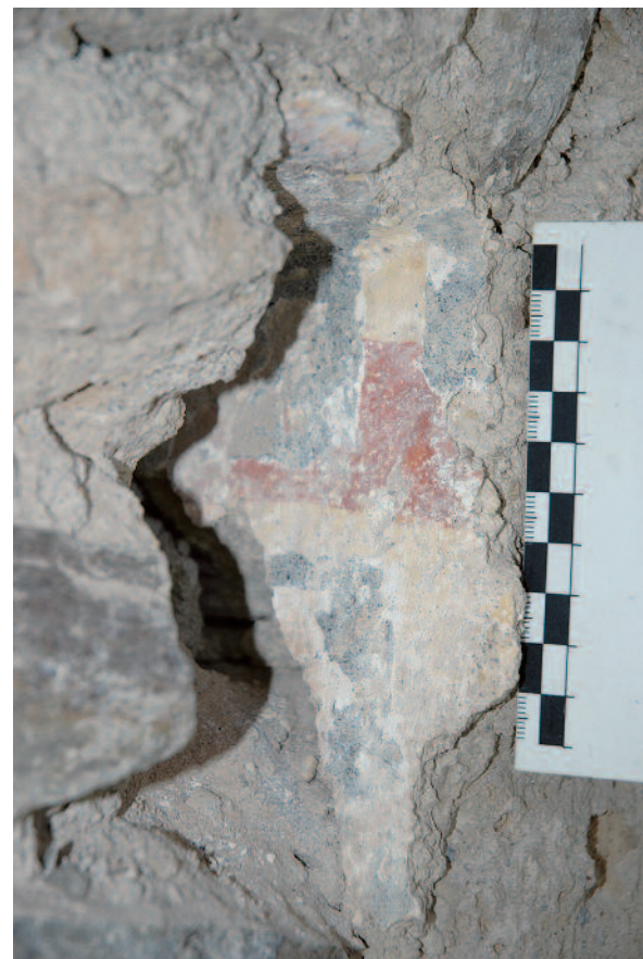
Abb. 10: Elisabethturm, glatter Laibungsputz mit der Erstfassung des 14. Jahrhunderts in hellockerfarbener und roter Farbgebung
