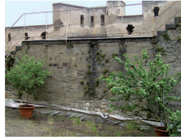
Abb. 8: Südöstlicher Umschlussgarten, Mauerflächen mit Kieselwurfputz oben und Rappputz unten (Foto 2002)
