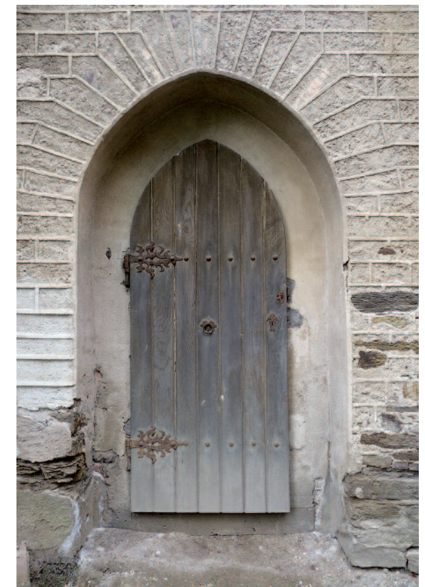
Abb. 5: Äußere Ringmauer Süd, Zugang zum Zwinger Garten mit Glattputz und Pietra-rasa-Flächen (Foto 2009)
