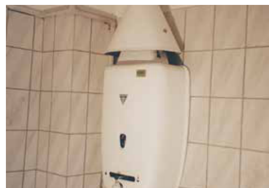
Veralteter Gasdurchlauferhitzer
