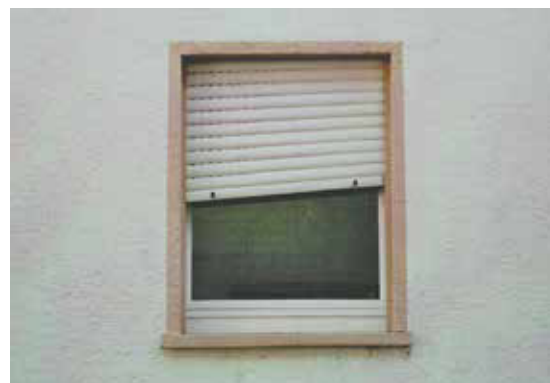
Defekter Rollladen
