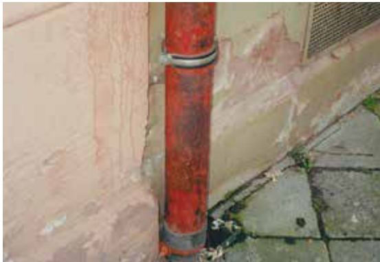
Stark verrostetes Gussrohr einer Regenrinne
