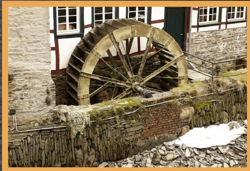
Das war einmal: Früher wurde der schwere Mühlstein über ein Wasserrad in der Senfmühle angetrieben
