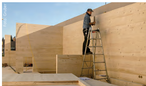
Entgegen aller Vorurteile punkten Massivholzelemente auch in puncto Brandschutz und halten einem Feuer stand.
