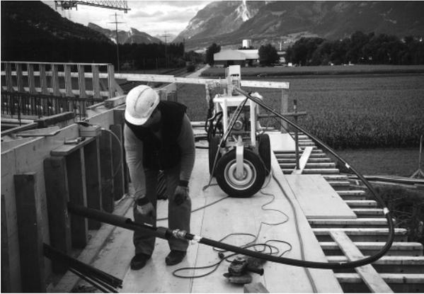
**Bild 19.** Einschieben von Spannstahl Litzen (Foto: PAUL Maschinenfabrik GmbH & Co. KG)
