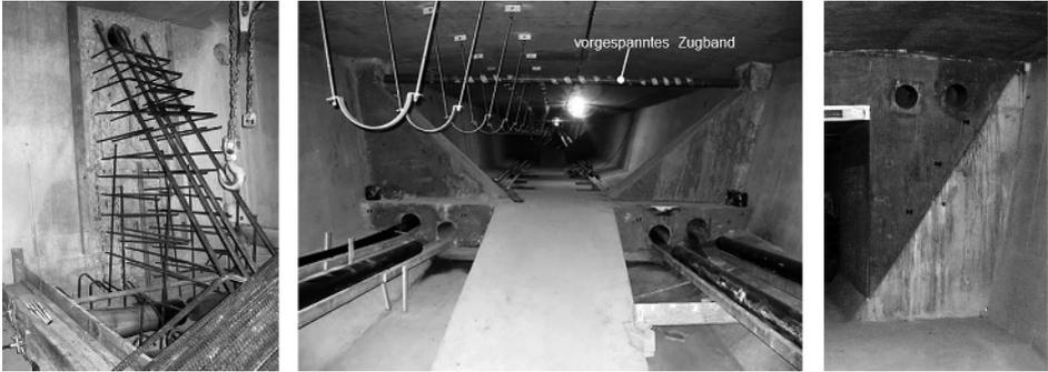
**Bild 75.** Einbau nachträglicher Umlenkstellen bei Kastenquerschnitten, im Feldbereich (links und Mitte; mit obenliegendem Querschnitt), Querschnittsergänzung an vorhandenem Stützquerträger (rechts)
