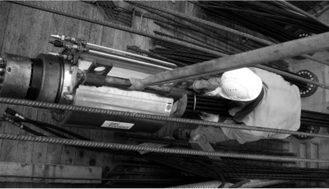
**Bild 20.** Anbringen einer Bündelspannpresse zum Vorspannen von Litzen-spanngliedern mit nachträglichem Verbund
