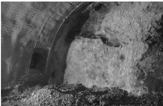
Bild 12. Sicherung des Einstiegs zur Karsthöhle 3, Zwischentunnelhöhle
