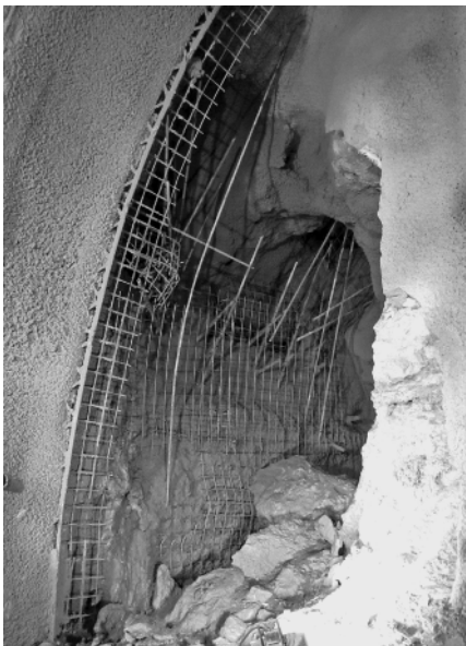
Bild 16. Ausräumen der Karststruktur und Herstellung eines seitlichen Widerlagers
