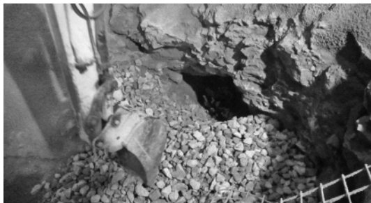
Bild 15. Verfüllen mit Grobschlag
