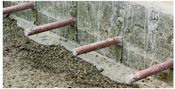
Eingebaute Dübel an Pressfuge
