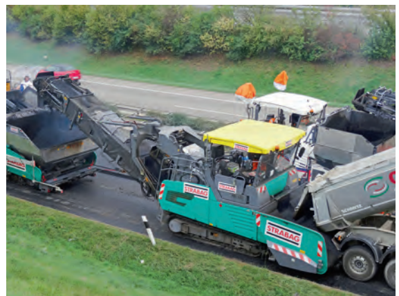
Mischgutübergabe durch einen Beschicker
