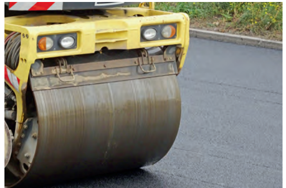
Berieselung der Bandage mit Wasser
