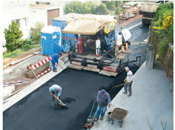
Handeinbau auf einer Restfläche
