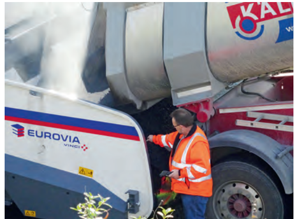
Temperaturmessung bei Mischgutübergabe
