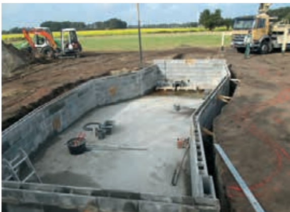
Abb. 3 Mauerbau für den Schwimmbereich
