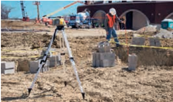
Abb. 1 Einsatz eines Baulasers in Kombination mit einem Laserempfänger; die Ausstattung mit einem sichtbaren Strahl ermöglicht ein schnelleres Erfassen der Sollposition mit dem Empfänger
