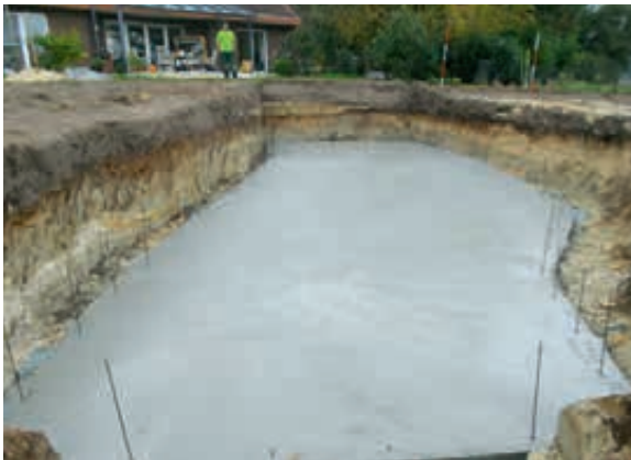
Abb. 2 Die Betonplatte für den Schwimmbereich ist gegossen
