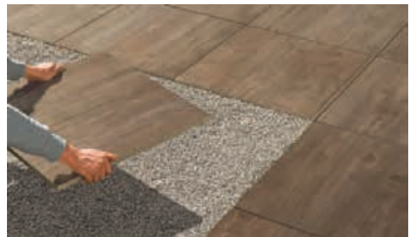
Abb. 2 Keramikplatten können von Hand verlegt werden
