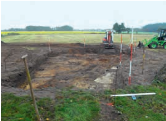
Abb. 1 Die genaue Lage des Schwimmteichs wird markiert; der Erdaushub erfolgt mit dem Bagger
