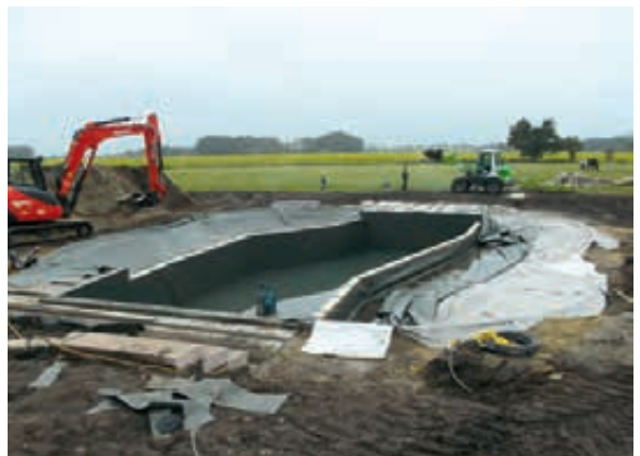
Abb. 6 Einbau von Vlies und Folie im Regenerationsbereich
