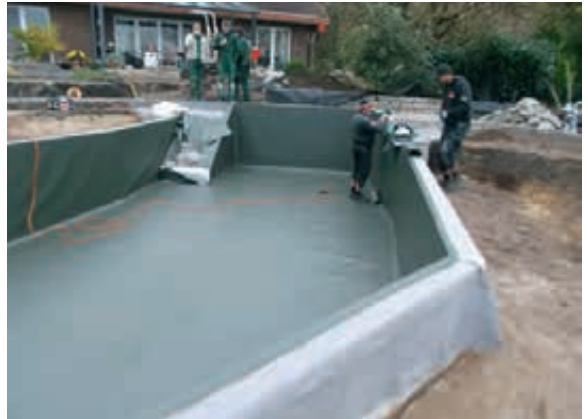
Abb. 4 Vlies- (300 bis 1000 g/m 2 ) und Folieneinbau (1,5 mm, z. B. aus Kautschuk); die einzelnen Vliesbahnen sollten sich 10 bis 20 cm überlappen. Die Folie wird maßgeschneidert in Rollen geliefert (s. Abb. 1 und 2, S. 448); sie ist möglichst faltenlos zu verlegen
