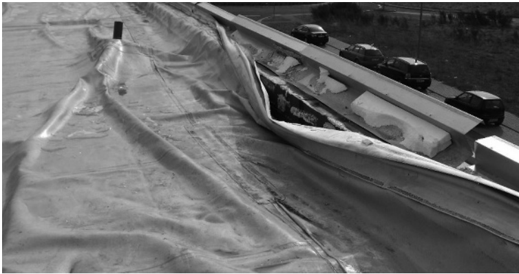
Bild 10. Nach einem Windexperiment mit Luftgeschwindigkeiten von 150 km/h wurde diese Dachabdichtung schwer beschädigt. Allerdings war der Dachaufbau fehlerhaft verklebt worden.
