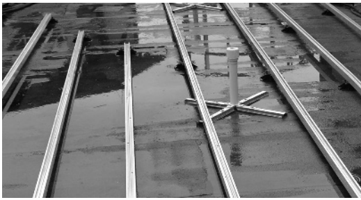
Bild 1. Wasserlachen auf einer Abdichtung einer Dachterrasse
