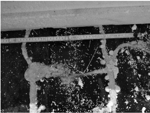
Bild 12. Auf die Dampfsperre war eine ausreichende Menge von Kleber aufgetragen worden. Allerdings hatten die EPS Dämmplatten nur zu einem sehr kleinen Anteil Kontakt zum Kleber. Zu einem Anteil von ca. 90 % blieb beim Verlegen der Platte ein Spalt zwischen deren Unterseite und der Kleberoberfläche.
