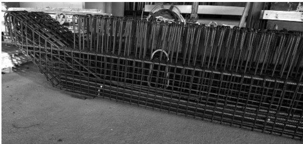
Bild 17. Bewehrung Fertigteilbalken
