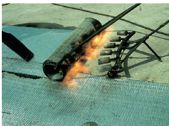
Verlegen von Schweißbahnen
