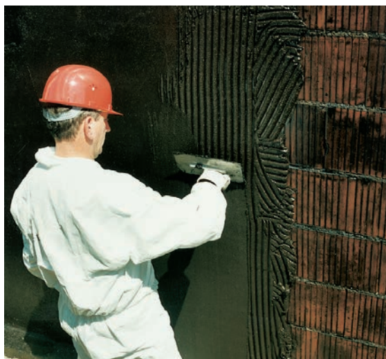
Aufbringen einer Dickbeschichtung
