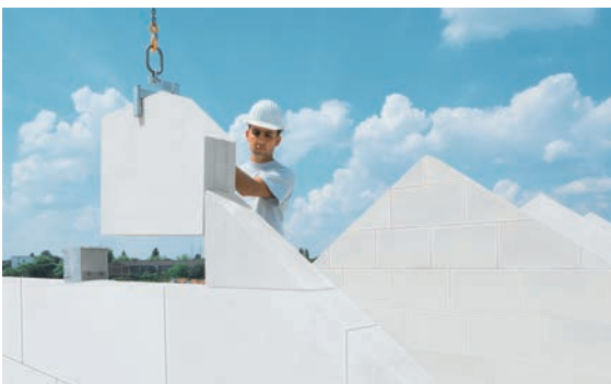
Versetzen von Kalksand-Planelementen
