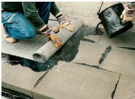
Verlegen von Dachdichtungsbahnen (Gießverfahren)
