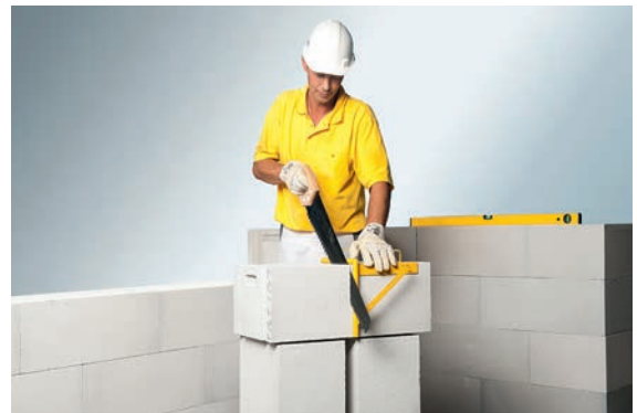
Maß- und passgenaues Sägen der Porenbetonsteine
