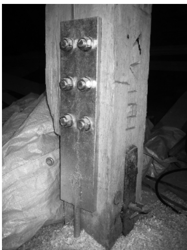
Bild 1.4 Maßstabsprengende „Reparatur“ eines völlig unbeschädigten historischen Anschlusses.
