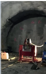
Brenner-Basistunnel H52 – Gebirgsinjektion (bis 100 bar Wasserdruck)
