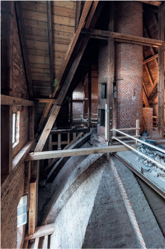
Die beiden Kuppelräume des Darrturms von oben betrachtet. Über jeder Kuppel thronte ein Schlot, über den feuchte Luft entweichen konnte
