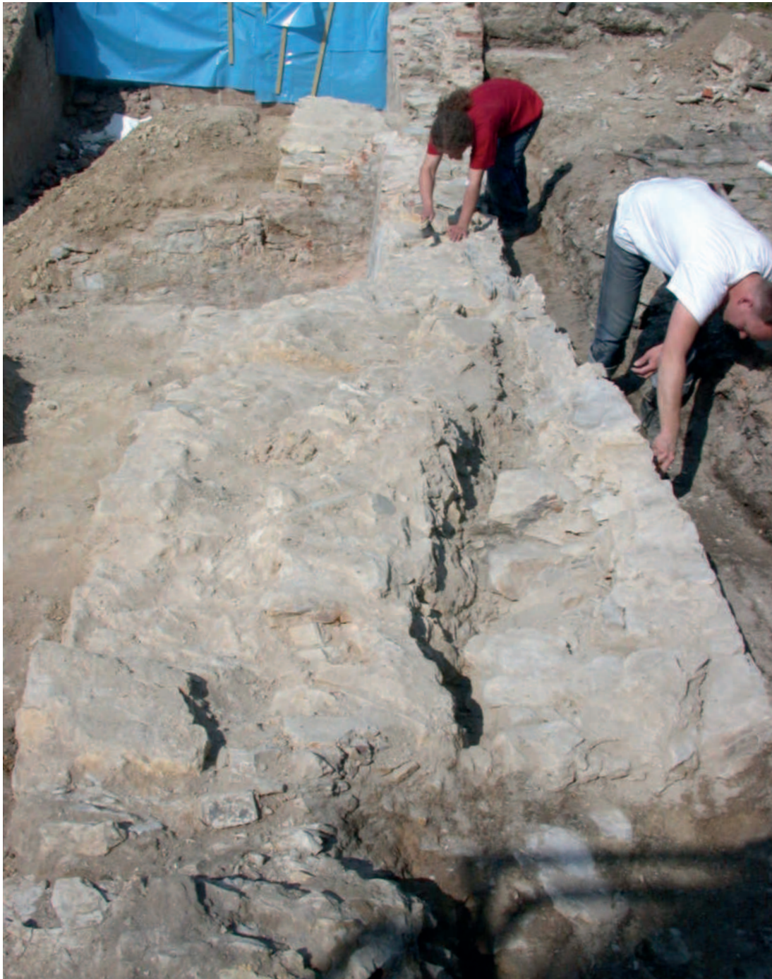
Abb. 4 | Grabung Busdorfmauer 2004, Stadtmauer mit Bau-schaden. Foto: LWL-Archäologie für Westfalen/Sven Spiong.
