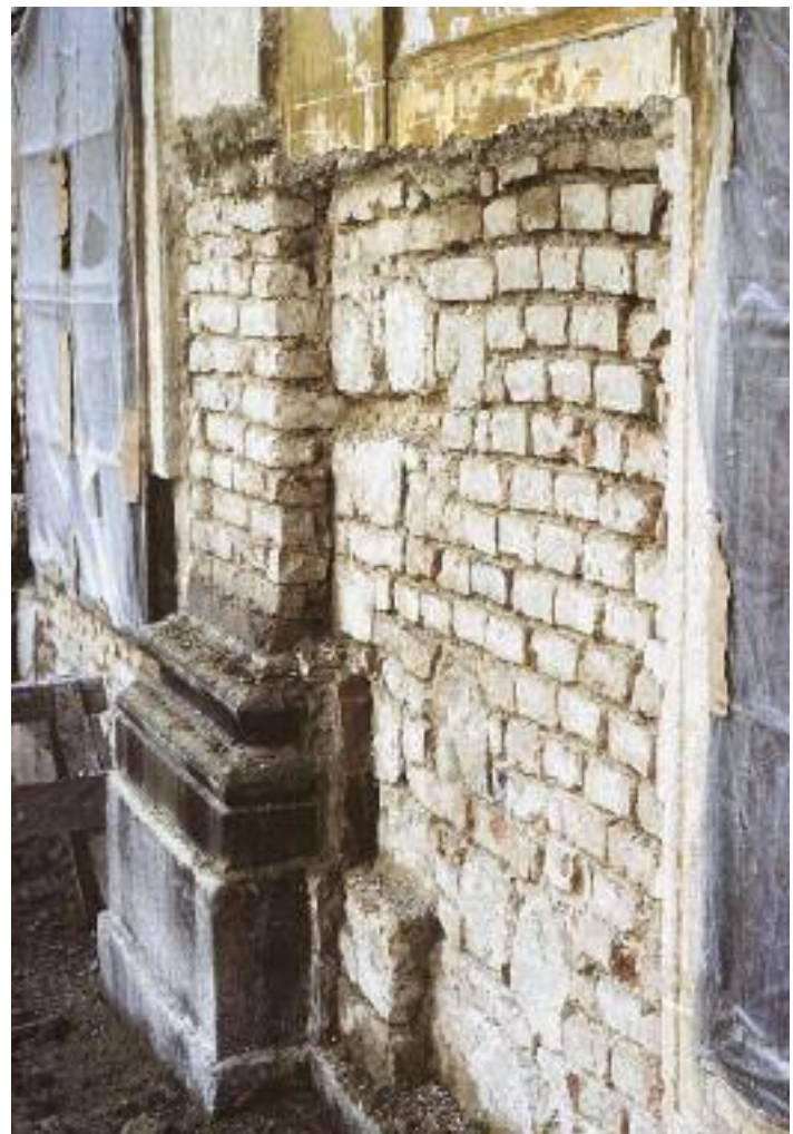
Abb. 13 Wien, Gartenpalais Schönborn, Hauptfassade mit freigelegtem älteren Mauerwerk (Foto: © Manfred Koller, Wien 1984)
