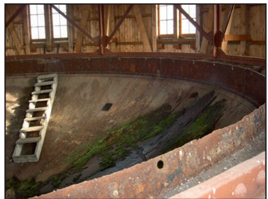
Blick in den Behälter
