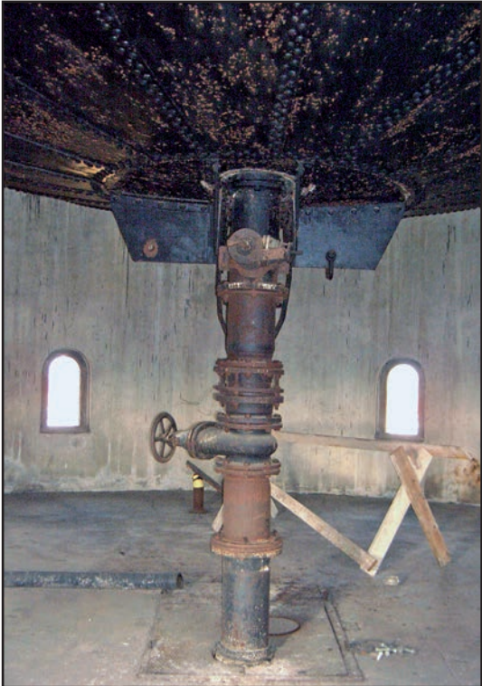
Wasserturm Möckern: Fallrohr unterhalb des Wasserbehälters
