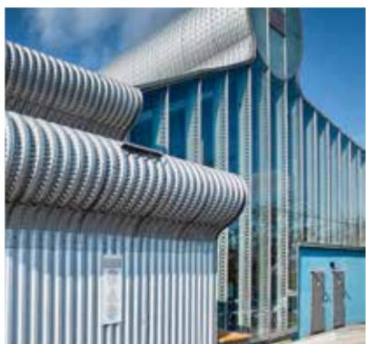
Freie geometrische Formen wie diese ondulierte Welle an diesem U-Bahnhof war erst mit dem Aufkommen industriell hergestellter Bauteile möglich. Heute sorgen Computer und CNC-Fräsen für Präzisionen, die früher nicht vorstellbar waren.
