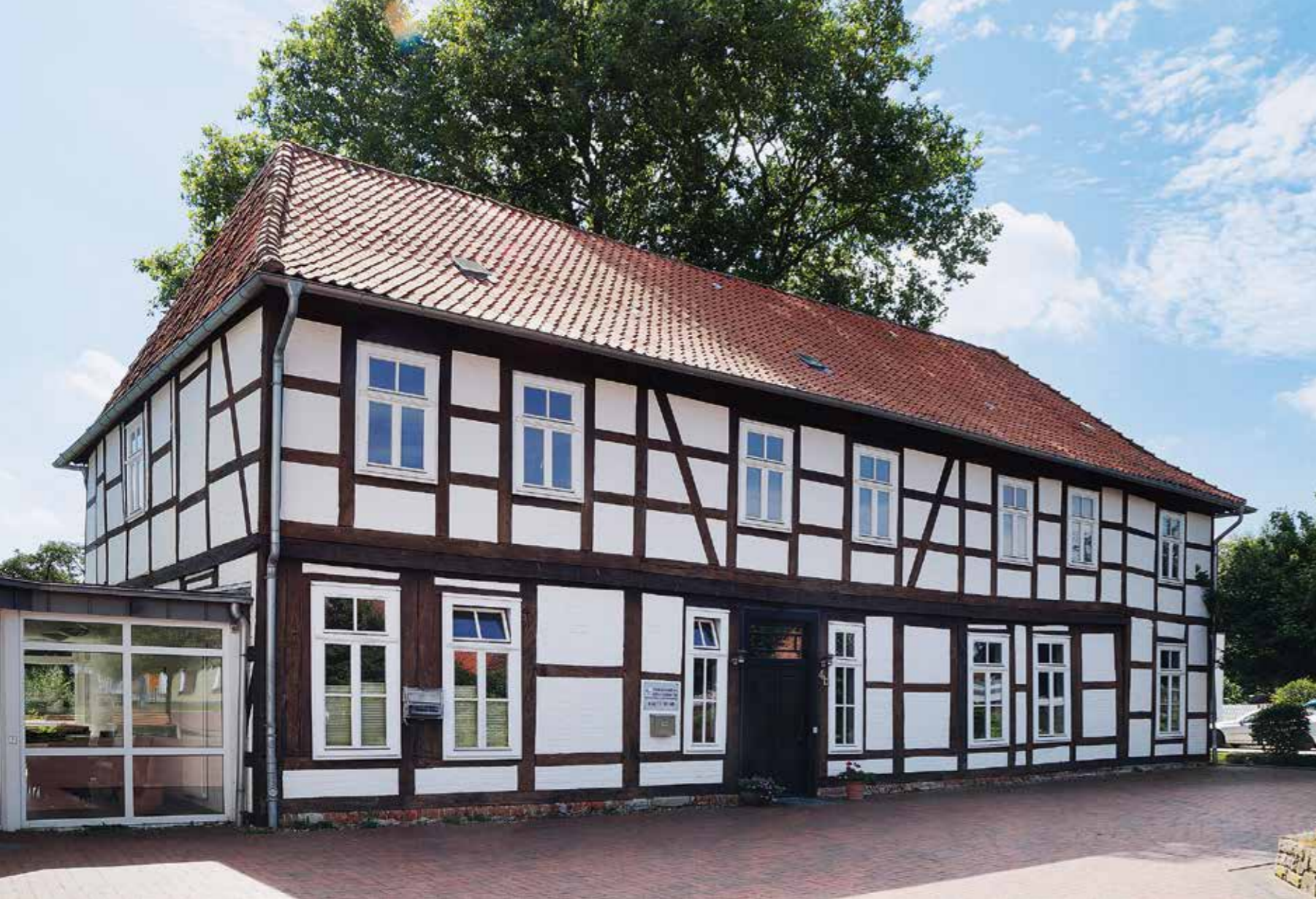
17 Rethem, ehemaliges Amtsschreiberhaus, Ansicht von NO 2021. (Foto: Sina Lübbehüsen)
