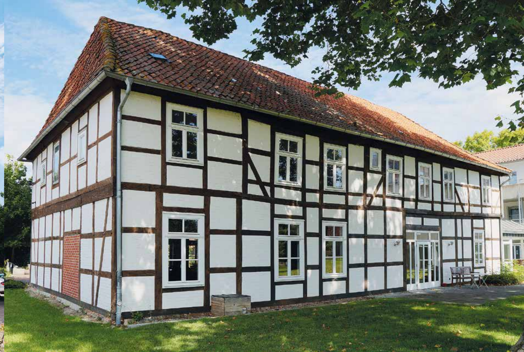
18 Rethem, ehemaliges Amtsschreiberhaus, Ansicht von NO 2021. (Foto: Sina Lübbehüsen)
