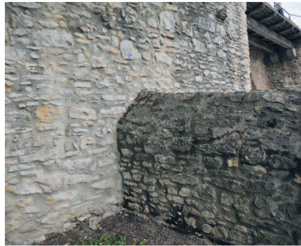
Abb. 14: Die Friedhofsmauer OI-Mb09 stößt gegen die Umwehrungsmauer OI-Mb06, keiner der Bruchsteine bindet ein. Sie wurde nach der Mauer OI-Mb06 gebaut, datiert aber in die Erste Bauphase.
