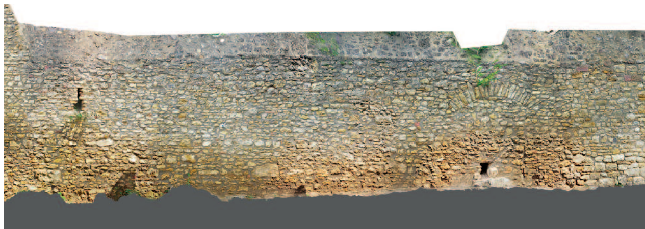
Abb. 15: Orthofoto der Westansicht von Mauer OI-Mb09. Auf der linken Seite ist die umgebaute Schlüsselscharte zu erkennen, auf der rechten Seite Bogen und Laibung des zugesetzten Durchgangs OI-PFb08 mit Entwässerungsöffnung innerhalb der Zusetzung.
