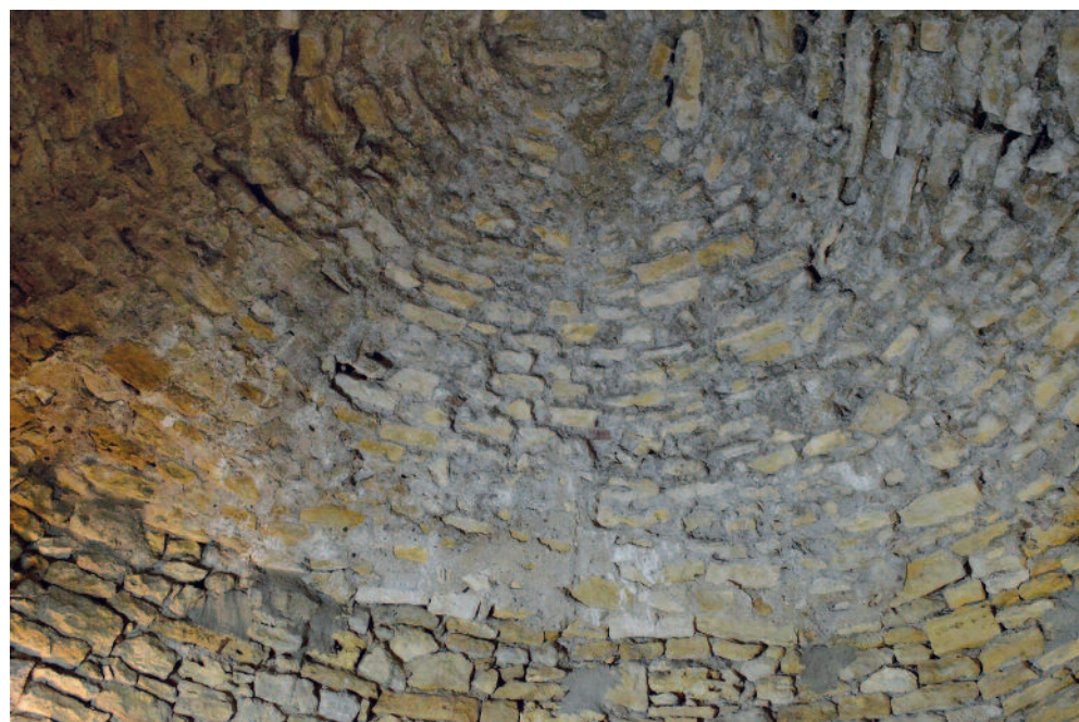
Abb. 12 Blick in das polygonal aufgebaute Kraggewölbe im 2. Obergeschoss des Malakoffturmes.
