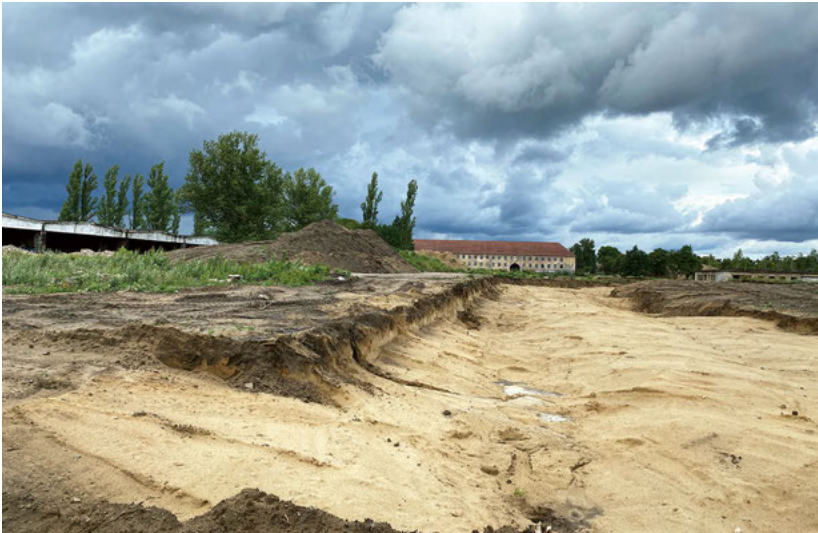
Bild 3 Baustellenplangebiet B nach Rodung, © Burkhard Friedrich
