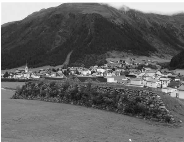
Bild 1-4 Beispiele des baulichen Lawinenschutzes: (a): Lawinenanbruchverbauung mit Schneenetzen (© Sauermoser); (b) Lawinenauffangdämme zum Schutz der Gemeinde Galtür (Tirol) (© Rudolf-Miklau)
