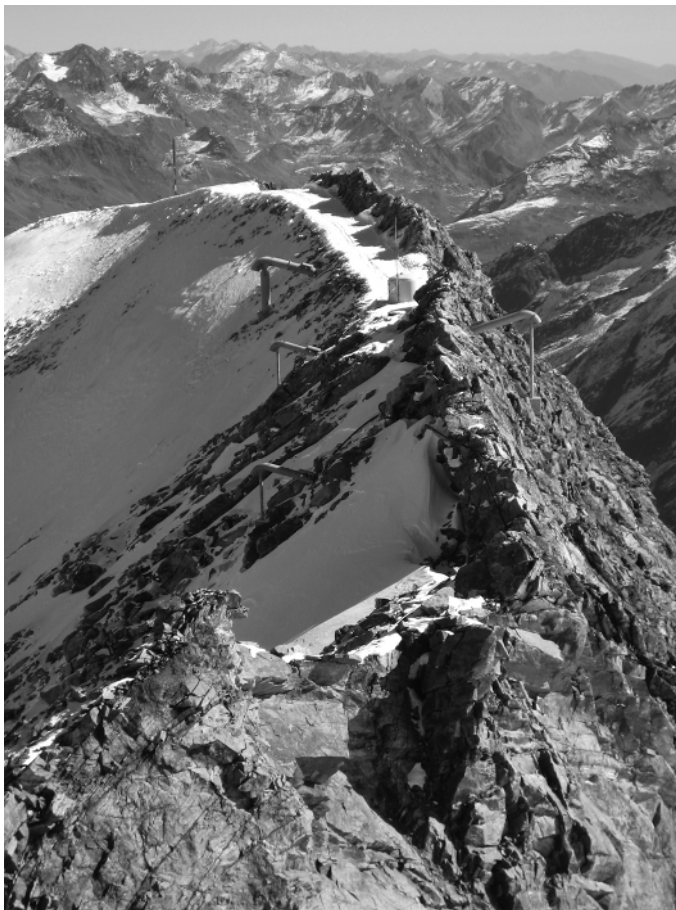
Bild 1-5 Künstliche Lawinenauslösung mit dem System Gaz.Ex (© Interfab Snowbusiness GmbH)
