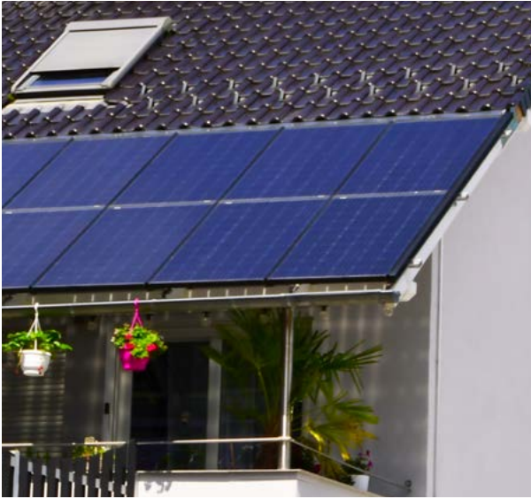
Abb. 6: Solarmodule als Balkonüberdachung ausgeführt. Hier müssen besondere Solarmodule verwendet werden.
