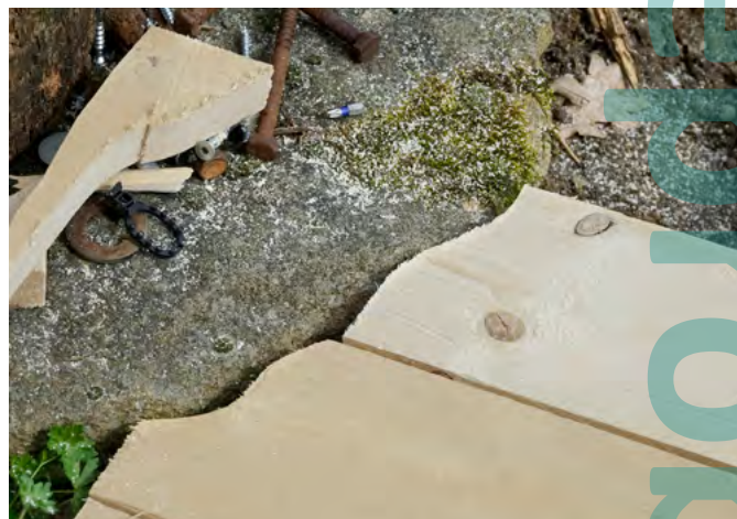
↑↓ An Bruchsteinmauern oder Wegbegrenzungen werden die Tragbohlen elegant-rustikal angepasst.
