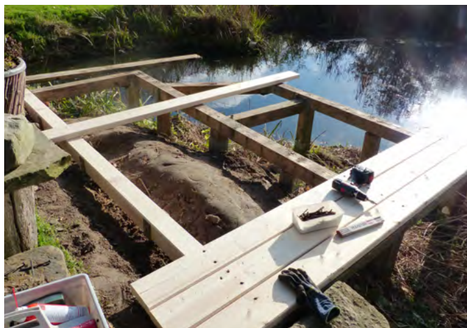
↑ Holzbohlenbelag auf stabilem Traggerüst trägt viele hundert Kilogramm Sapienspower.
