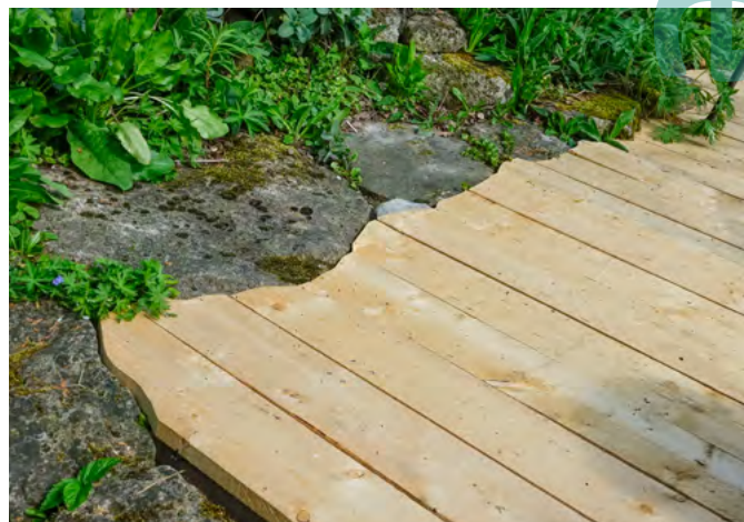
↑↓ An Bruchsteinmauern oder Wegbegrenzungen werden die Tragbohlen elegant-rustikal angepasst.
