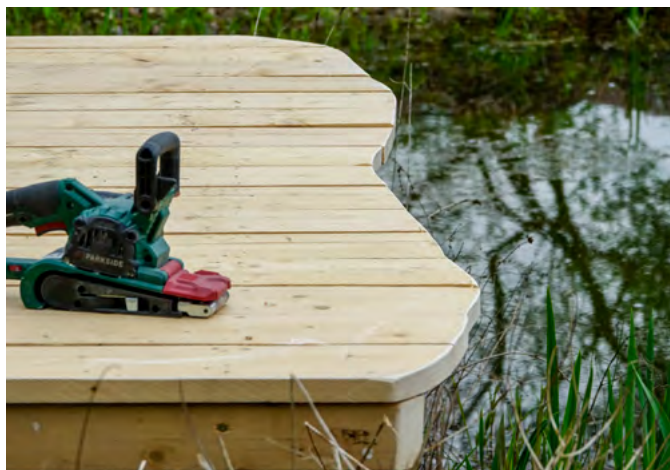
↑ Feinschliff: Terrassengrenzen können geschwungen gestaltet, Kanten mit dem Bandschleifer gebrochen werden.
