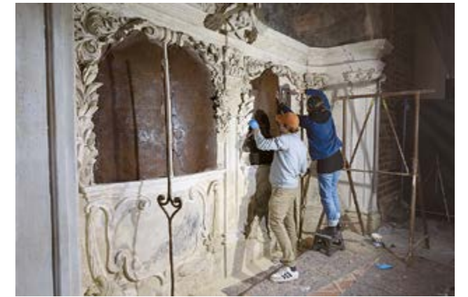
Abb. 3: Frankfurt (Oder), Marienkirche, barockes Erbbegräbnis, Remontage der Metalltafeln mit Inschrift, Bild: M. Noll-Minor 2024
