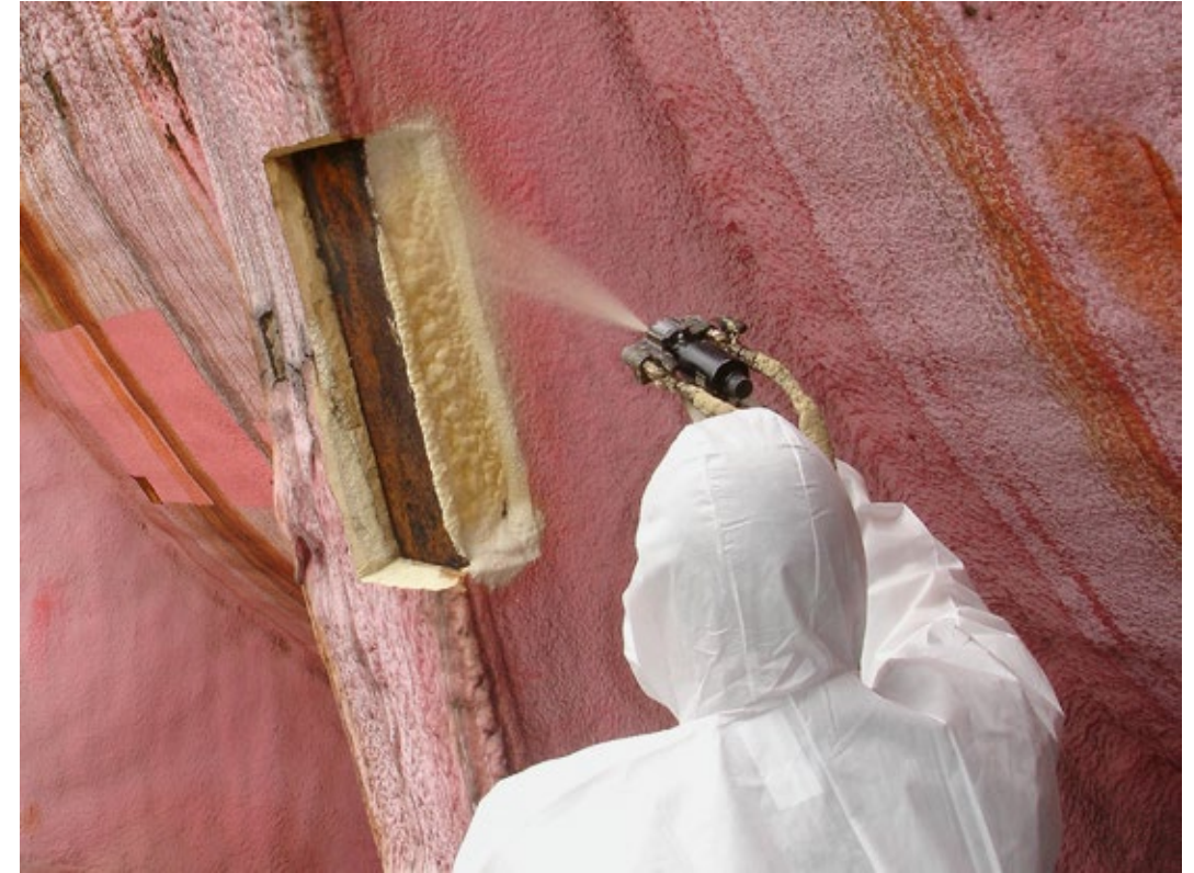
2 Minimalinvasive und materialgerechte Sanierung der Ummantelung der Röhren des Umlauftanks 2 der TU Berlin mit PU-Schaum, 2017
