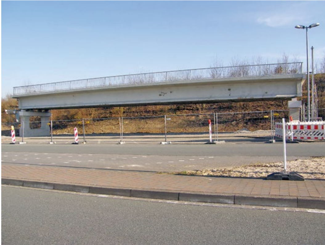
1 Der an die Raststätte Vellern translozierte Brückenüberbau der ehemals die A2 überquerenden Brücke »Überführung Weg Hesseler«. Sie war 1938 eine der ersten im Spannbettverfahren errichteten Brückenbauten der Welt und ist seit 1991 eingetragenes Denkmal.
