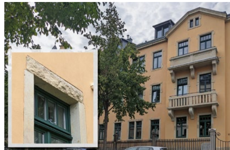
3 Doppelhaus mit neuen Fensterrahmen und Glaskonstruktionen Wilder-Mann-Str. 17 in Dresden-Trachau. Detailaufnahme: isolierverglastes Oberlicht mit Floatglas
