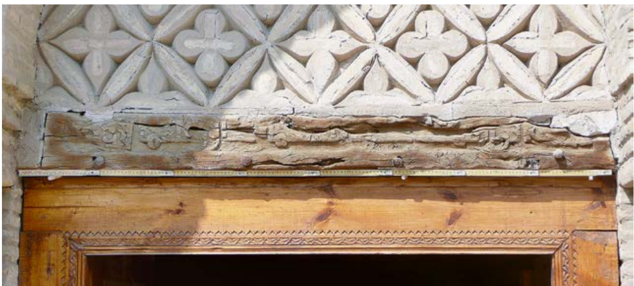
Abb. 3 · Samaniden-Mausoleum. Sturzholz mit Inschrift aus Wachholderholz. Eißing 2009
