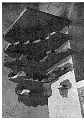
1118: a–d) Buchara, Herstellung von Stuck-Muqarnas, 1960. In einer 135°-Ecke sollte eine 6-schichtige Muqarnas-Dekoration aufgebracht werden. Die Grundlage war ein exakt geometrisch konstruierter Schichtenplan. Mit Hilfe dieses Schichtenplans konnte für jede Schicht eine Schablone aus einer Gipsplatte ausgeschnitten werden; b) Diese Schablonen befestigte man an dem schiffsbogenförmigen Gipsträger in der festgelegten Höhe jeder Muqarnas-Schicht; c) und d) Nun wurden die einzelnen Muqarnas-Zellen von oben nach unten offensichtlich freihändig mit Kelle und Stuckateureisen, vielleicht auch Holzlehren ausgefüllt (NECIPOĞLU 1995, 47).
