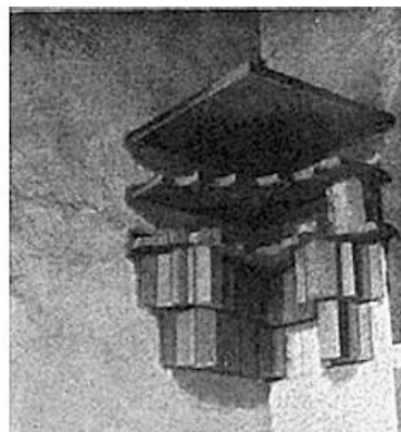
1118: a–d) Buchara, Herstellung von Stuck-Muqarnas, 1960. In einer 135°-Ecke sollte eine 6-schichtige Muqarnas-Dekoration aufgebracht werden. Die Grundlage war ein exakt geometrisch konstruierter Schichtenplan. Mit Hilfe dieses Schichtenplans konnte für jede Schicht eine Schablone aus einer Gipsplatte ausgeschnitten werden; b) Diese Schablonen befestigte man an dem schiffsbogenförmigen Gipsträger in der festgelegten Höhe jeder Muqarnas-Schicht; c) und d) Nun wurden die einzelnen Muqarnas-Zellen von oben nach unten offensichtlich freihändig mit Kelle und Stuckateureisen, vielleicht auch Holzlehren ausgefüllt (NECIPOĞLU 1995, 47).
