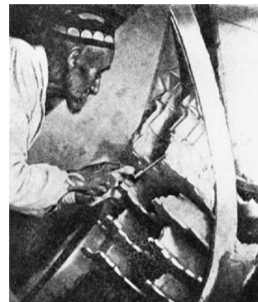
1118: a–d) Buchara, Herstellung von Stuck-Muqarnas, 1960. In einer 135°-Ecke sollte eine 6-schichtige Muqarnas-Dekoration aufgebracht werden. Die Grundlage war ein exakt geometrisch konstruierter Schichtenplan. Mit Hilfe dieses Schichtenplans konnte für jede Schicht eine Schablone aus einer Gipsplatte ausgeschnitten werden; b) Diese Schablonen befestigte man an dem schiffsbogenförmigen Gipsträger in der festgelegten Höhe jeder Muqarnas-Schicht; c) und d) Nun wurden die einzelnen Muqarnas-Zellen von oben nach unten offensichtlich freihändig mit Kelle und Stuckateureisen, vielleicht auch Holzlehren ausgefüllt (NECIPOĞLU 1995, 47).
