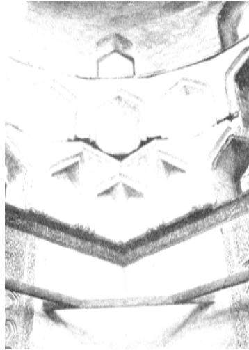
1114: Kairo, Mausoleum von Šağar ad-durr, 1250. Überleitzungszone mit Muqarnas-Elementen aus Backstein verputzt, wie die Fehlstelle (am rechten Bildrand) erkennen lässt (BRIGGS 1924, Abb. 74).
