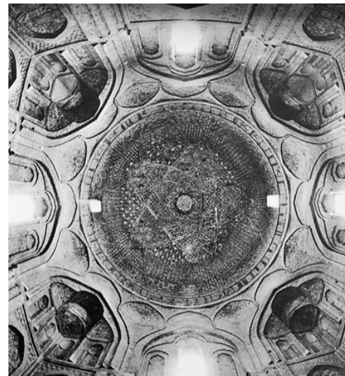
1112: Isfahan, Freitagsmoschee, überwiegend 11. Jh. Nördlicher Kuppelraum: a) Trompen-Überleitung mittels der Drei-in-eins-Lösung; b) Blick in die Kuppel (HOAG 1976, 196, 197).
