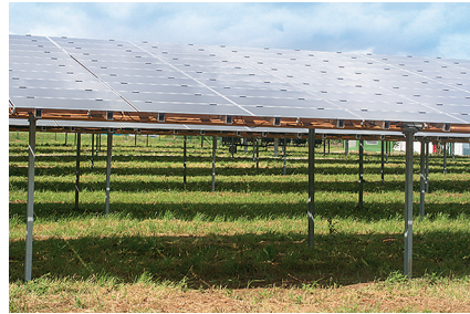
Abb. 7 und 8: Solargeneratoren auf einem konventionellen Dach (links) und Solargeneratoren auf Ständerwerk in einer Wiese (rechts). (Fotos: Wolf, Bad Hersfeld)
