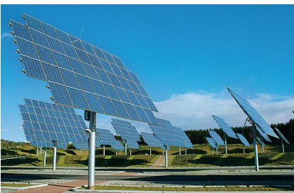
Abb. 9 und 10: Nachführsysteme (links). (Foto: Wolf, Bad Hersfeld) und drehbares Gebäude (rechts). (Foto: Solartechnik Stiens GmbH & Co. KG, Kaufungen)
