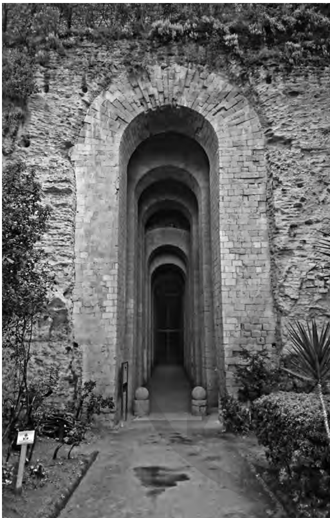
7 Posillipo, Grotta di Seiano, Zugang von W mit Sicherungsmaßnahmen des 19. Jhs. (2016)
