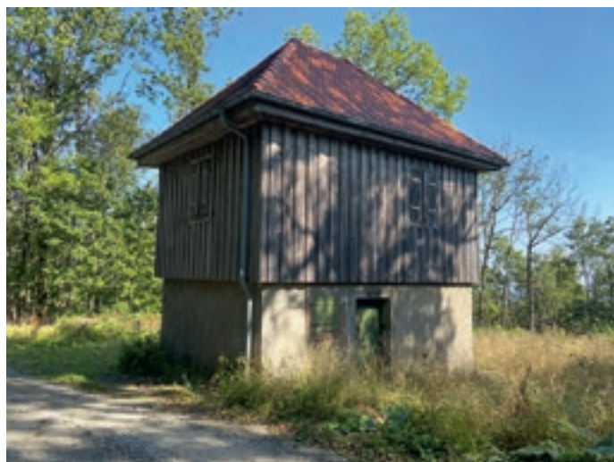
Abb. 167: Jagdhütte in der Steinruh am Totnansberg. Zweigeschossiger Walmdachbau mit verputztem Erdgeschoss und verbrettertem Obergeschoss, bez. 1840.
