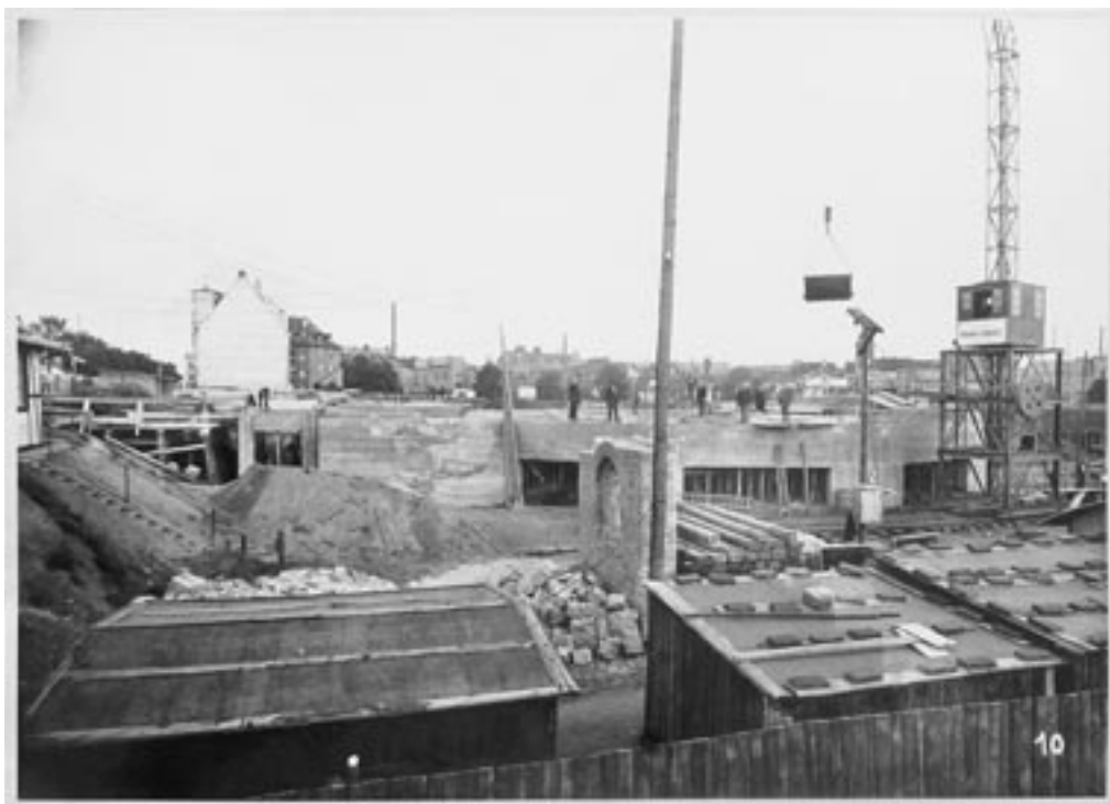
Baustelle der Erlöserkirche mit Probewand, zweischaliges Mauerwerk mit Bogenfenster, Foto: Emil Westphalen, September 1930
