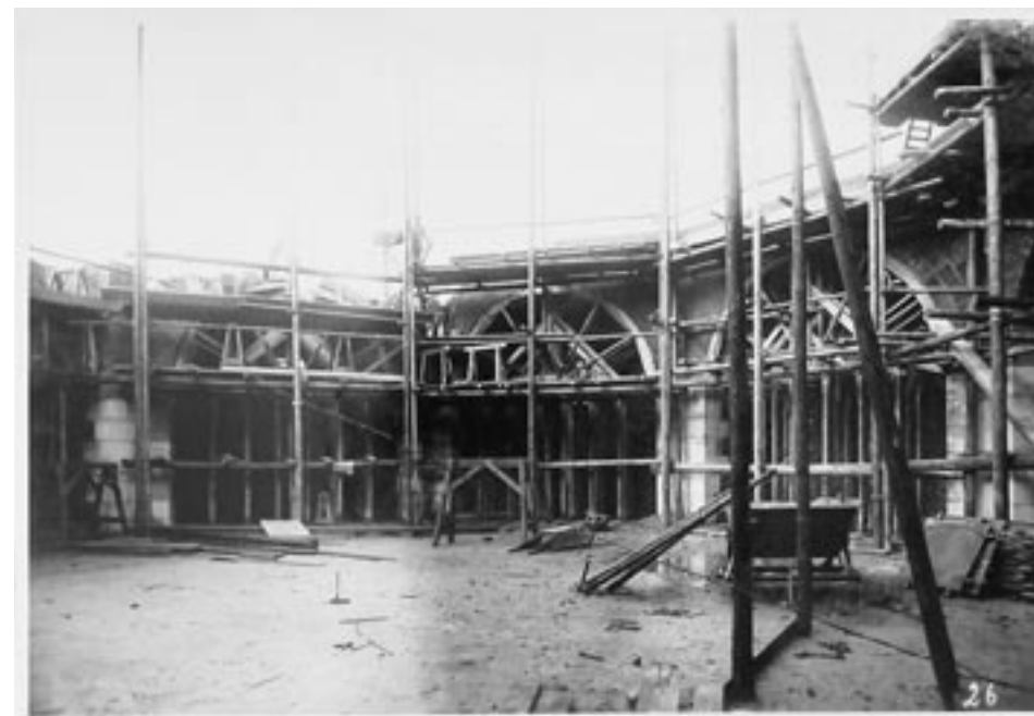
Die Bögen des Kapellenkranzes werden über hölzernen Lehrbögen gemauert, Foto: Emil Westphalen, 25.10.1930
