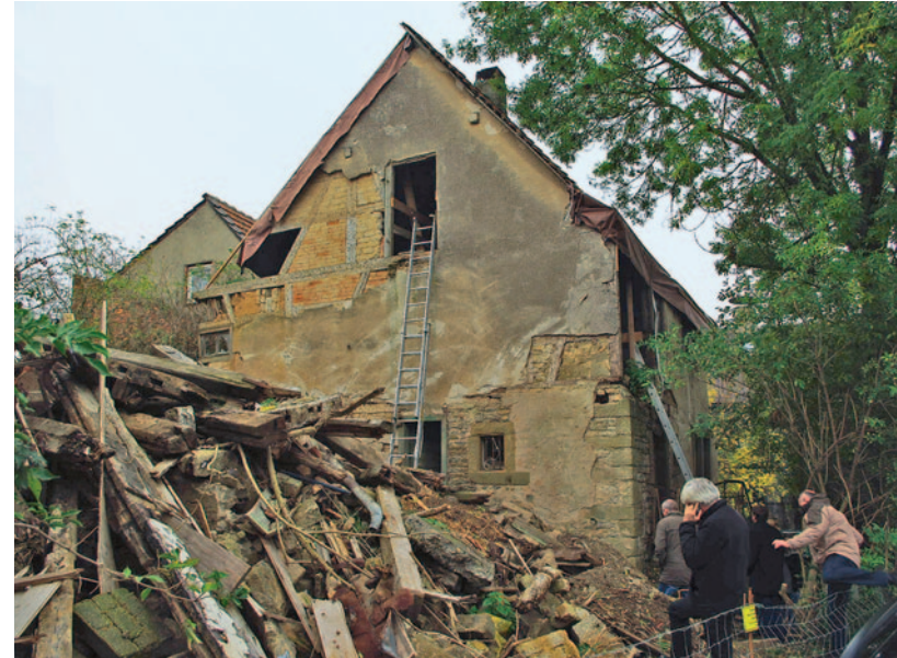
Abb. 2 — Eine innere Erschließung gab es in dem Gebäude zuletzt nicht mehr, die Treppenanlage war eingestürzt. Um ins Ober- und Dachgeschoss zu gelangen, musste außen eine Leiter angelegt werden. Im Vordergrund das eingefallene Nachbargebäude. Aufnahme 2012. (Foto: Freilandmuseum Bad Windsheim, Dieter Gottschalk)
