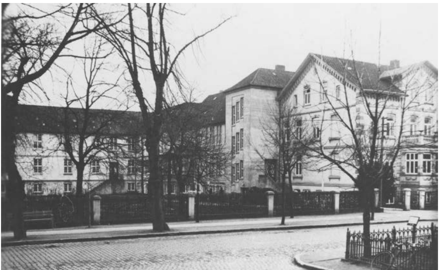
1.1 Krankenhaus in der Bahnhofstrasse (auf dem Gelände befindet sich heute das Stadthaus), Aufnahme um 1939 Stadtarchiv Buxtehude, Fotosammlung. Foto: Bolde.
